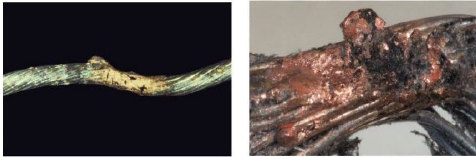
図 5.1.3 電気配線のアーク痕跡 13)
